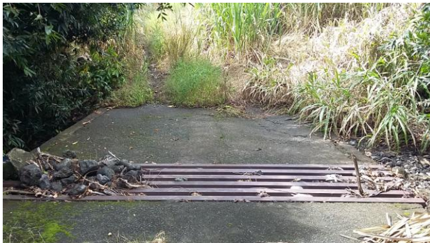
Chemin béton 30 m et radier
